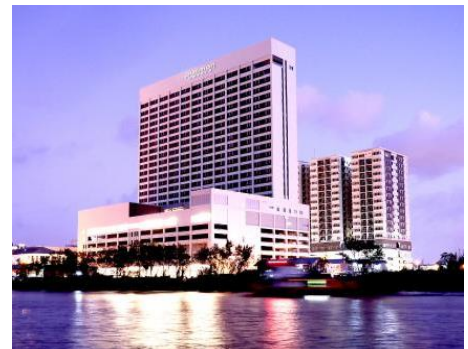
Pullman Hotel cum condominium, Miri
